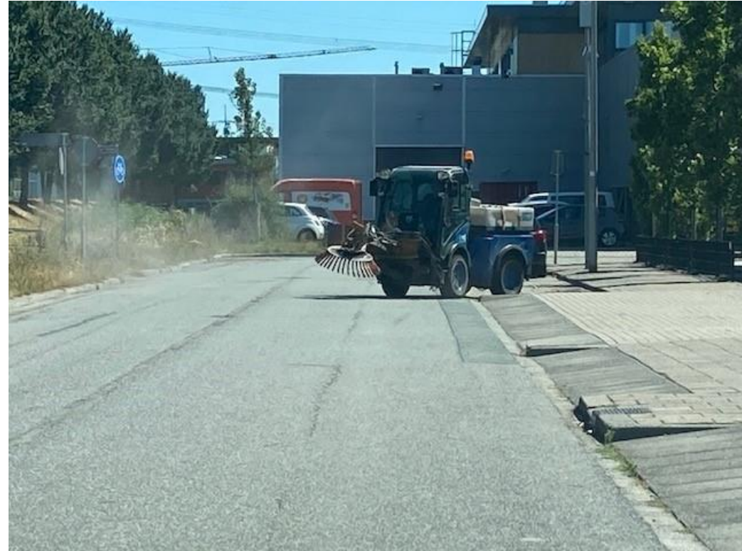
Werkzaamheden op de Turfschipper
